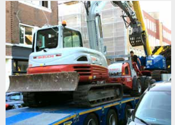
Aanvoer materieel tbv totaalsloop.
